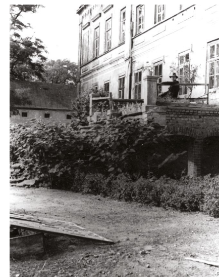
Pałac na terenie obozu Kulmhof, w którym Niemcy przygotowywali ofiary do zagazowania. Ze zbiorów IPN
